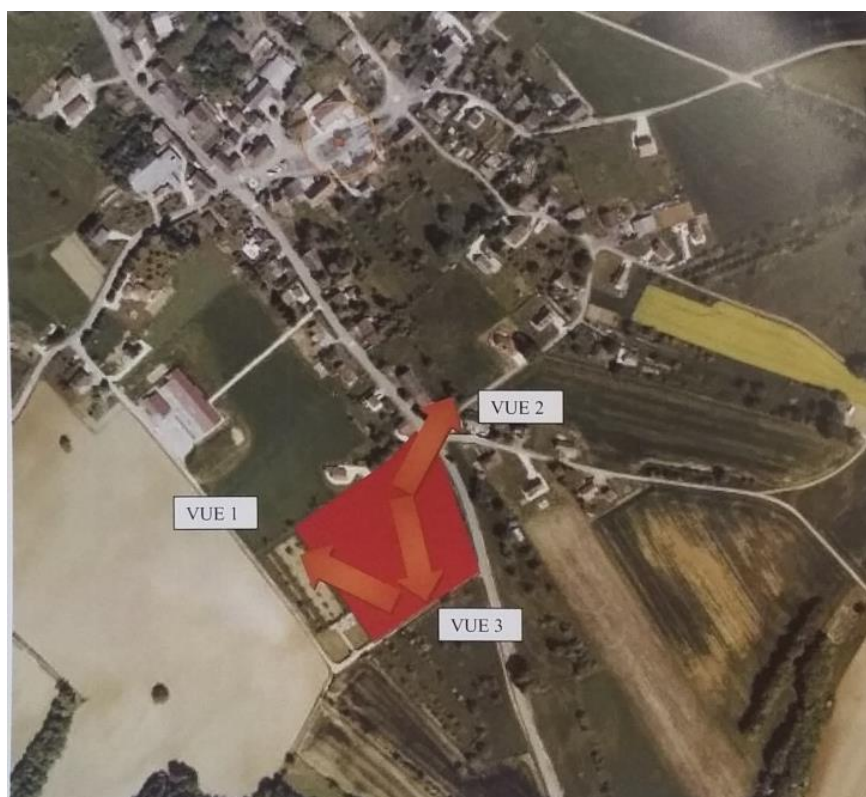
Photo aérienne – vue lointaine du projet
