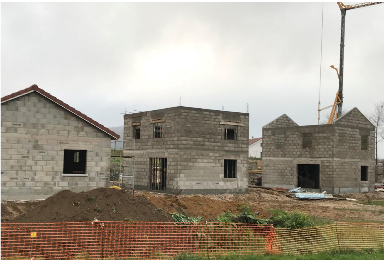
Les deux premiers T4 en cours de construction
